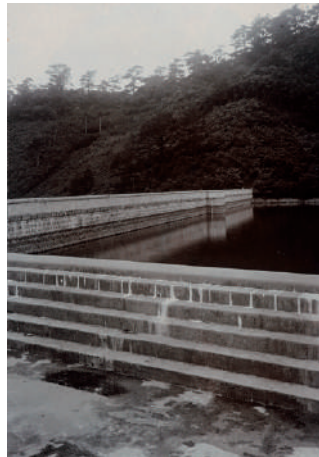
43. 長崎本河内水源地
