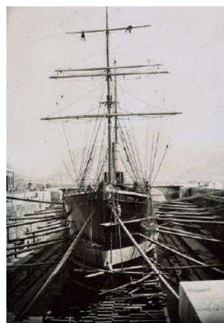
58. 三菱長崎造船所第三船渠の修理船
